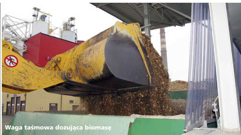
Biomasa w zbiorniku pośrednim
