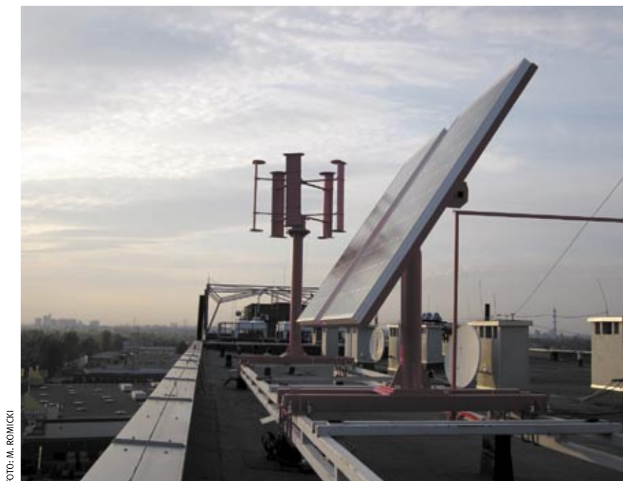
■ HYBRYDOWY SYSTEM ZASILANIA NA DACHU BIUROWCA TAURON WYTWARZANIE
